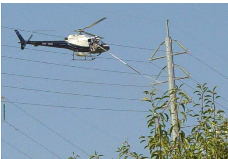
Σχήμα 4. Καθαρισμός Γραμμής Μεταφοράς 150kV του Συστήματος Κρήτης, υπό τάση, με ελικόπτερο
