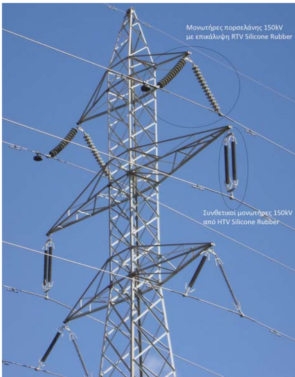
Σχήμα 1. Μονωτήρες ανάρτησης σε Γραμμή Μεταφοράς 150kV του Συστήματος Κρήτης
